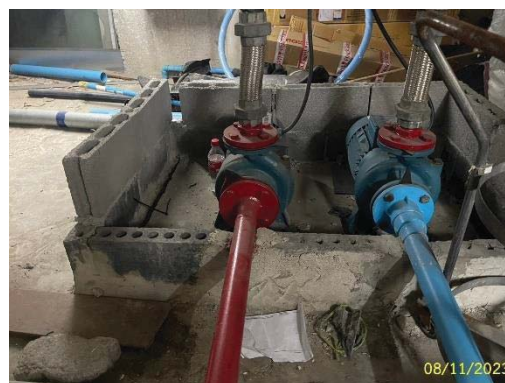
บ้มและถังเก็บน้ำใช้ใต้ดิน
